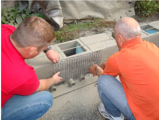
Fixação S&P ARMO-mesh
