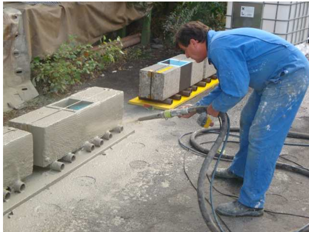
Projeção de S&P ARMO-crete w aprox. 1 cm
